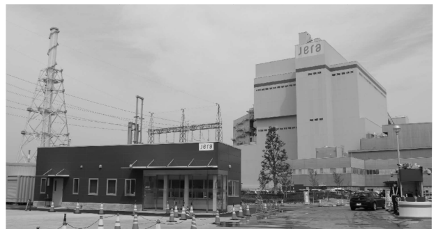
正門から見た武豊石炭火力発電所
