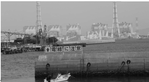
武豊火力発電所のすぐ目の前に見える碧南火力発電所（武豊火力発電所の北側から）
