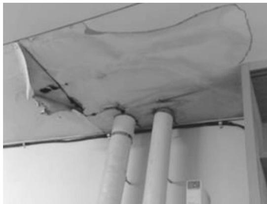
ますが、似たような状況は多くの県立学校にもあります。【B校の武道場の床】穴が空いたり床が剥がれているところをガムテープで補修してある。武道場とは柔道や剣道をやる場所です。裸足でやるので本当に危ないわけですが、県に言っても直してもらえないので、先生たちが補修をしている状況です。【C校の自転車置き場の屋根】穴があいています。石をぶつけたわけでもないのに穴が空いている。屋根の瓦もボロボロになっています。【D校の救助袋】破れているので、これを使ったら危ない。だから救助には使えません。【E校の雨漏り】県立高校の雨漏りはひどい状況です。この学校では天井が剥がれ、さらに3階から漏れ
